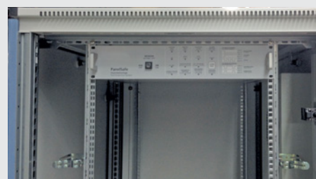
Detailfoto: eingebautes 19"-Löschsystem im Schrank TiRAX "cool & safe"
