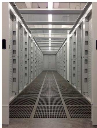
*Zwecks abschließender Einhausung stehen Flurabdeckungen und Schiebetüren (sowohl elektrisch als auch mechanisch) zur Verfügung (Warm-/Kaltgangeinhausung).*
