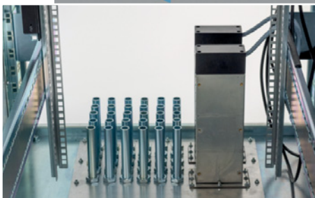
Abb. 4 Stromversorgung über hochwertige, leistungsstarke Filter. Lichtwellen- leiter werden durch PG-Rohre eingeführt.
