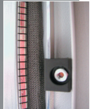
Abb. 2 Türabdichtung mit Kontaktfedern und Drahtgeflechtdichtung
